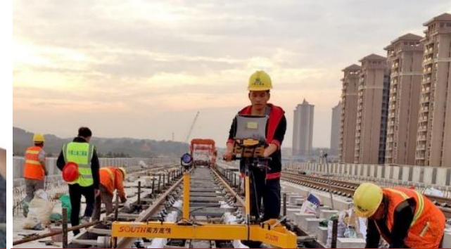
广州市轨道交通21号线轨道工程精密测量
