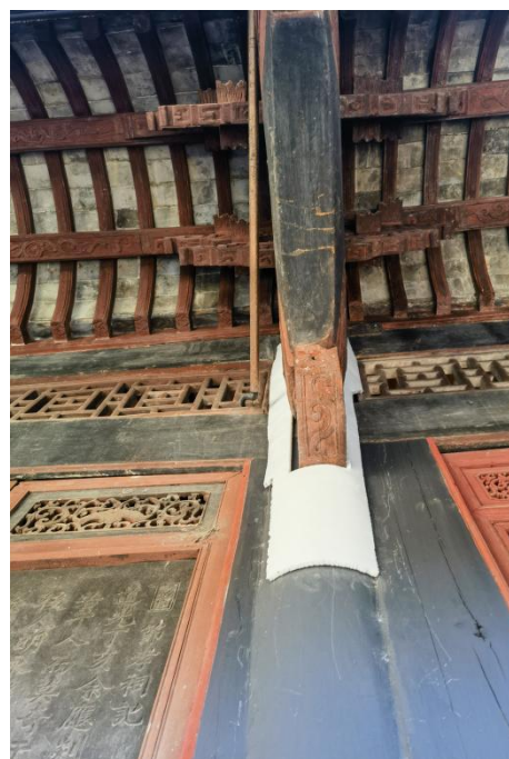
图 31 外部打印构件试安装
