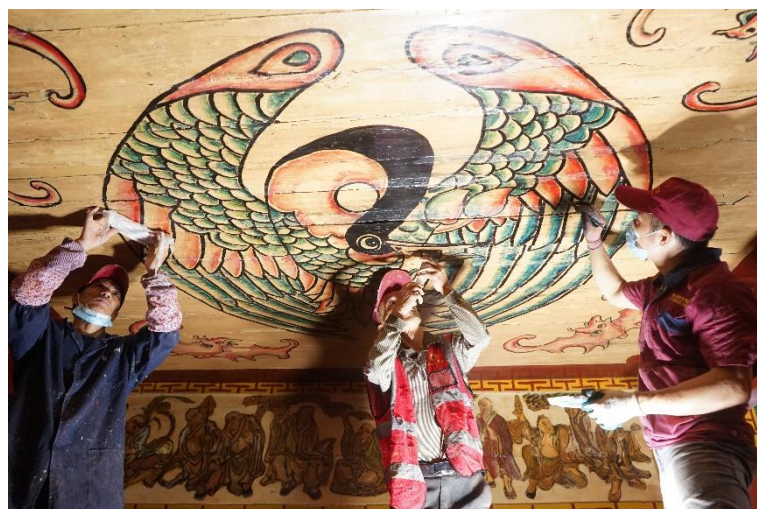
图 05 南天寺自在佛殿天棚彩绘可逆性回贴修复
