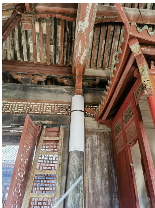
图 30 内部打印构件试安装
