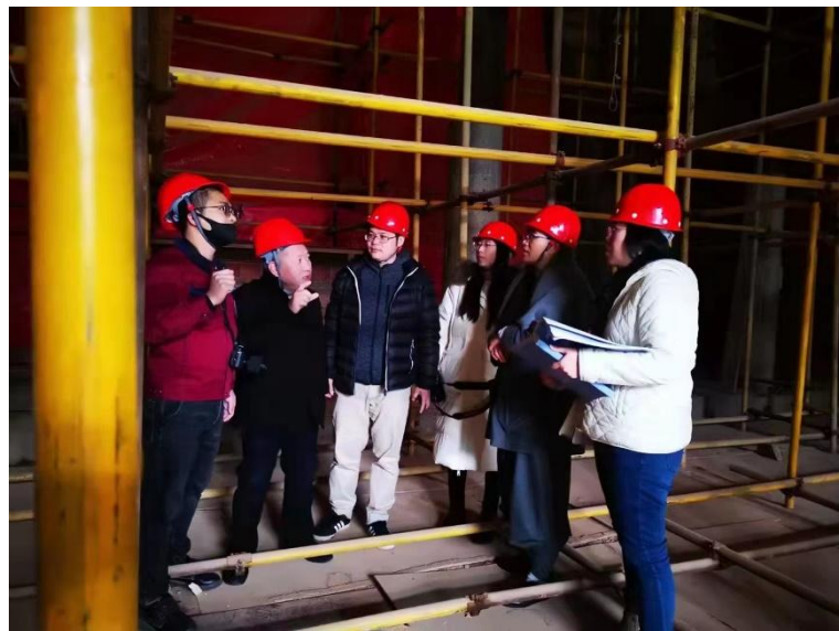
图 07 施工过程中各方联合现场指导
